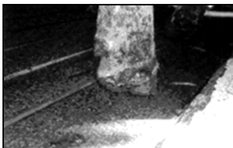
Foto 6.- Erosión de talón
